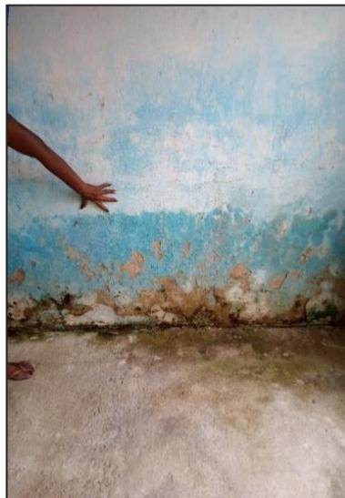
Figura 8 – Mancha representando do nível da água dentro dos domicílios durante a inundação.
