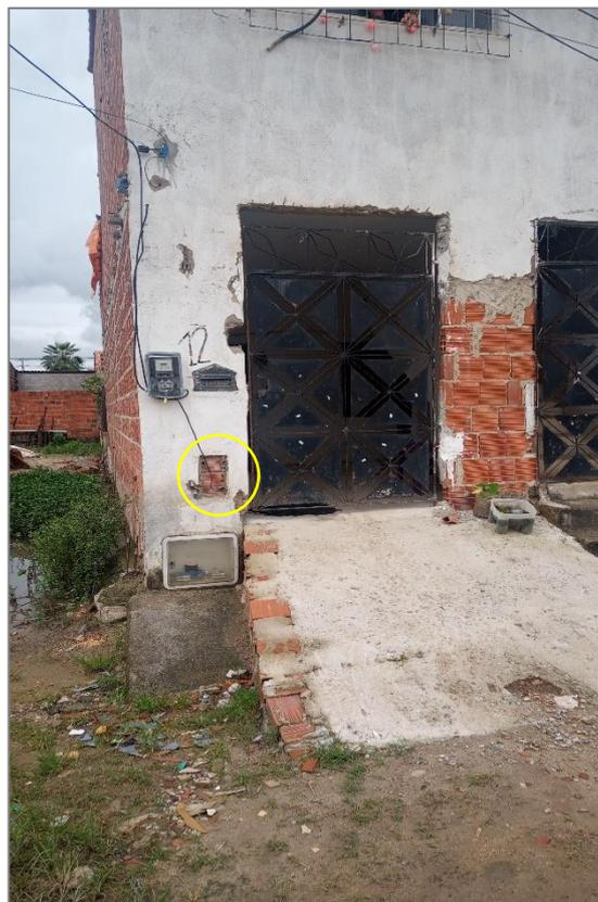
Figura 9 – Intervenção de moradora que elevou o nível a calçada, o medidor de energia e o piso da casa para conter a entrada de água. Fonte: Autor, 2022.
