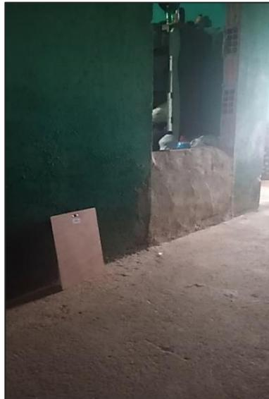
Figura 7 – Batente construído na porta do quarto para evitar a entrada de água durante uma inundação.
