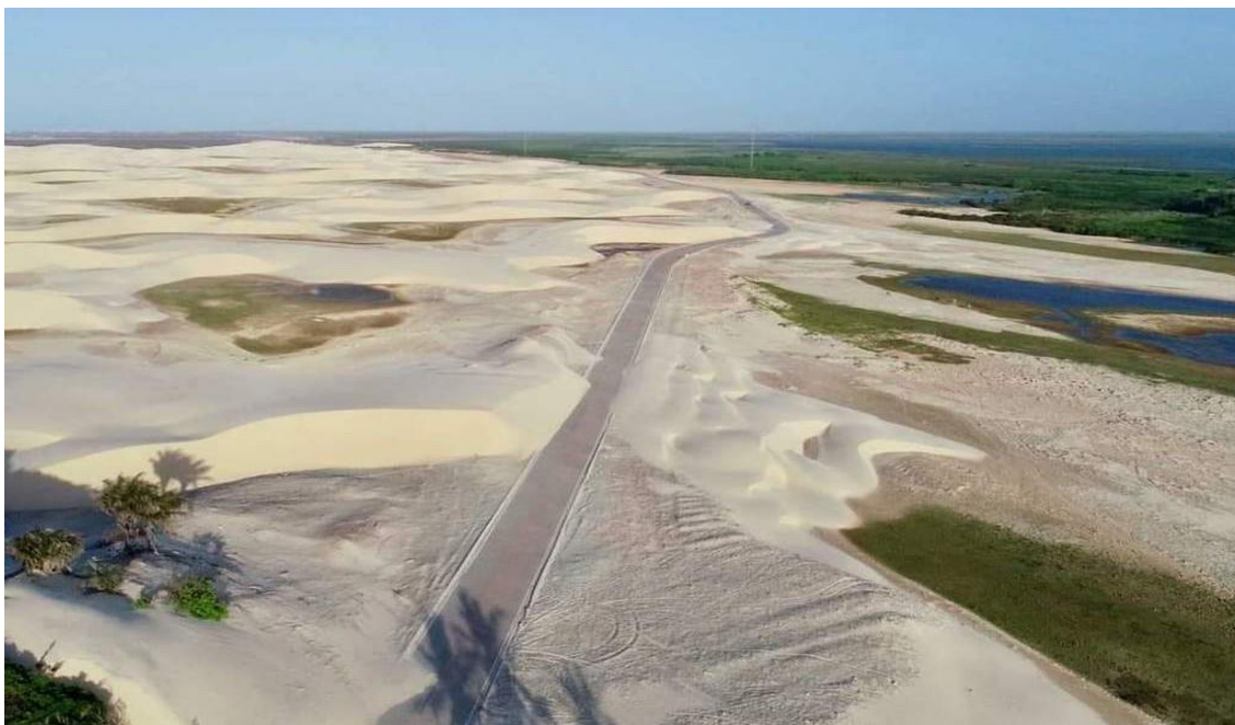
figura 2: Trecho da MA-315 construído em área de dunas móveis Fonte: correioma.com.br
