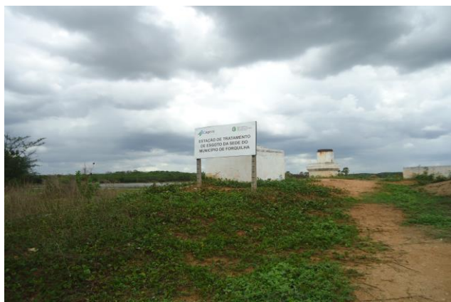
Figura 1: Entrada da estação de tratamento de esgoto (ETE).
