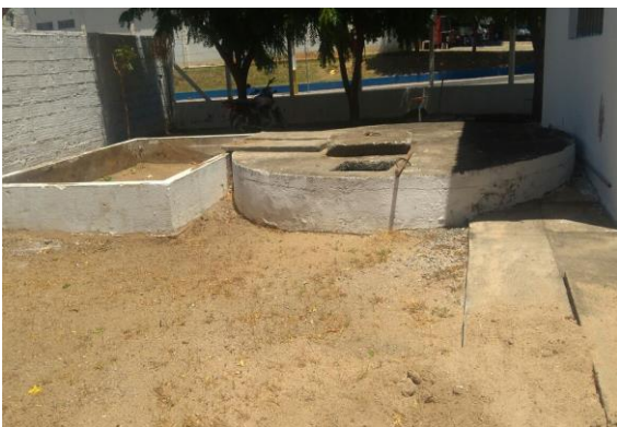
Figura 2: Poço de reunião dos efluentes.
