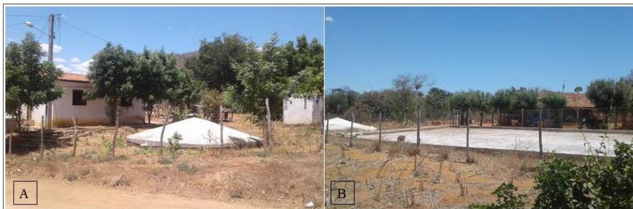
**Figura 1** – Cisterna enxurrada na comunidade de Salgado dos Mendes (A); e cisterna calçadão na comunidade de Caiçara (B), ambas em Forquilha (CE).
