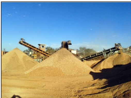
Fig. 1: Britador de RCD.
