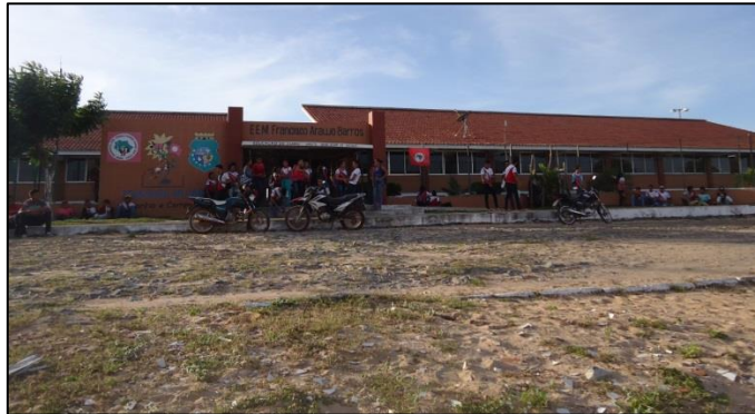
(Figura I) Fachada da EEM Francisco Araújo Barros. Fonte: OLIVEIRA, 2017.
