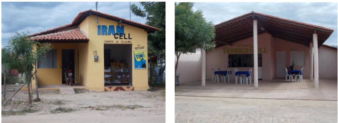
Figura 3: Exemplos de unidades habitacionais que compõem os Residenciais Planalto Petecas e Planalto Recreio.
