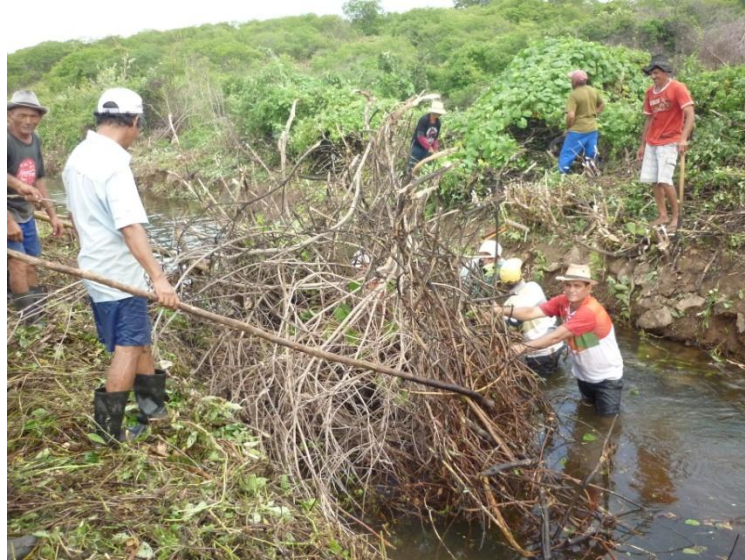
Fig. 1: Retirada de Entulhos do Canal de Adução
