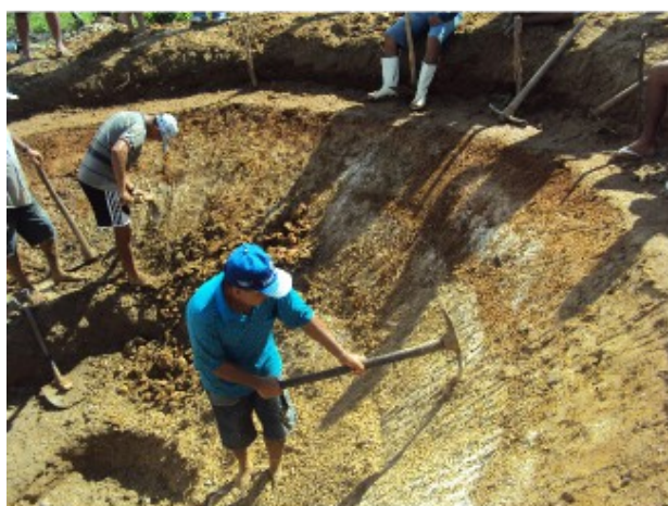
Figura 1. Escavação do tanque de irrigação.
